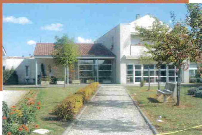
Ci contre, un exemple de réalisation en Lot et Garonne La MARPA de Prayssas
